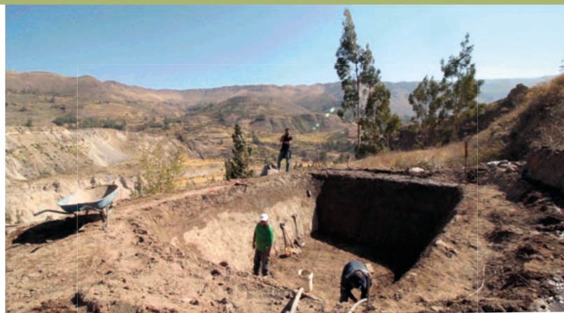
Excavación de un reservorio y la zanja que sujeta la geomembrana.
