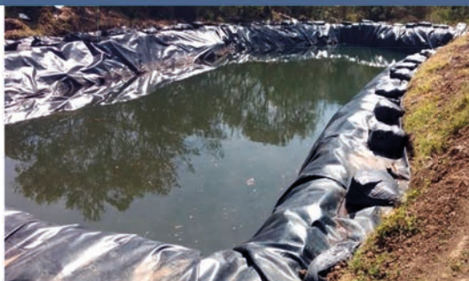
Reservorio con la geomembrana instalada. La zanja se rellena para sujetar la membrana una vez lleno el reservorio.
